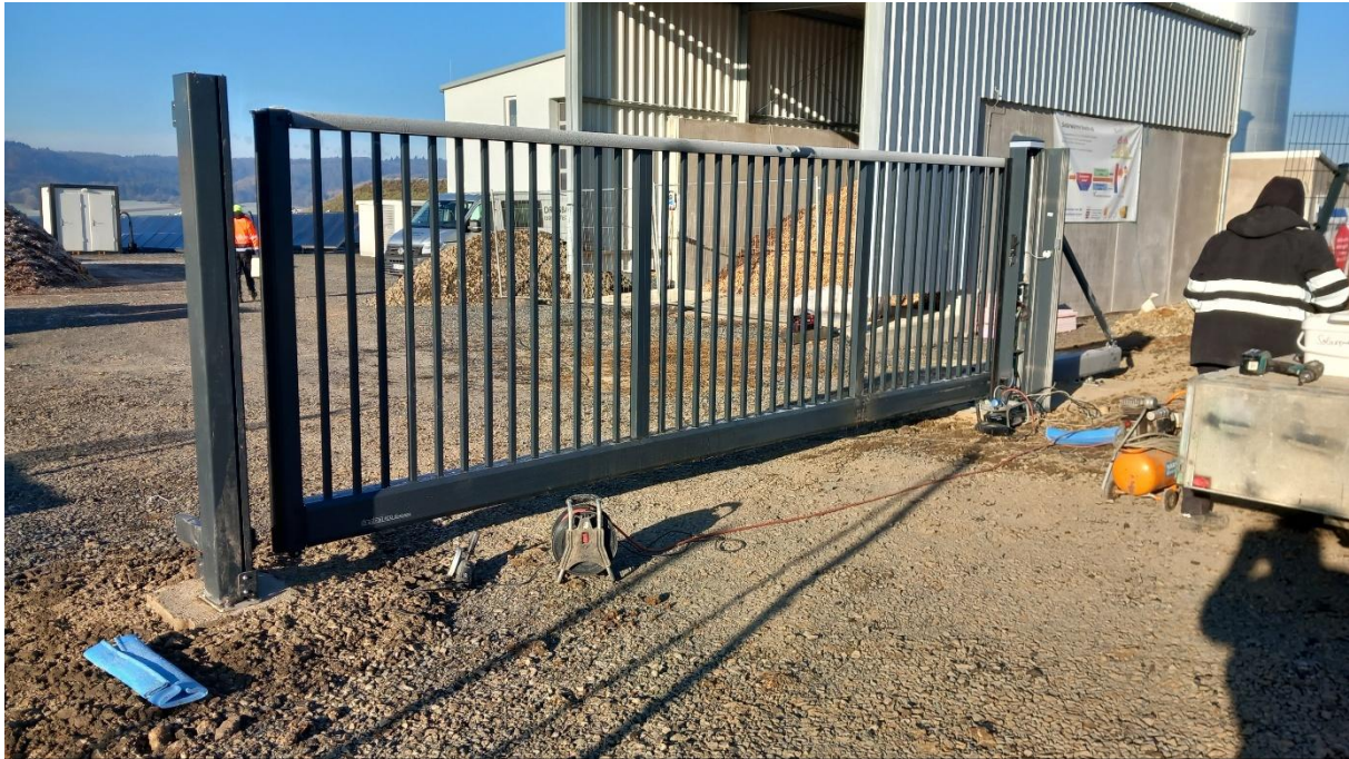
Das große Tor der Anlage. Im Hintergrund sieht man die Holzhackschnitzel im Schubboden. Dort werden die Hackschnitzel automatisch zum Brenner befördert.
