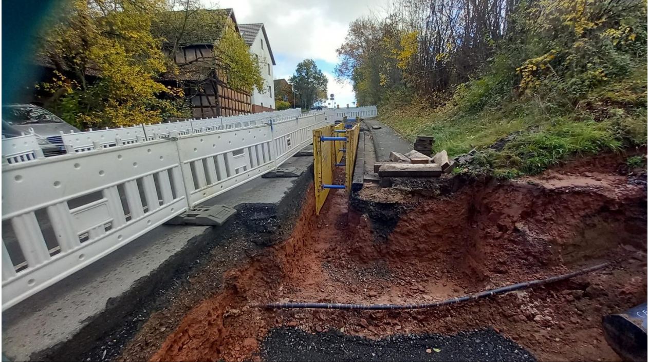
Bracht-Richtung Schwabendorfer Straße. Der Graben ist ausgehoben. Ziel bis Ende November: Auf der Höll anschließen und die Leitung bis Anfang Albsgarten verlängern.
