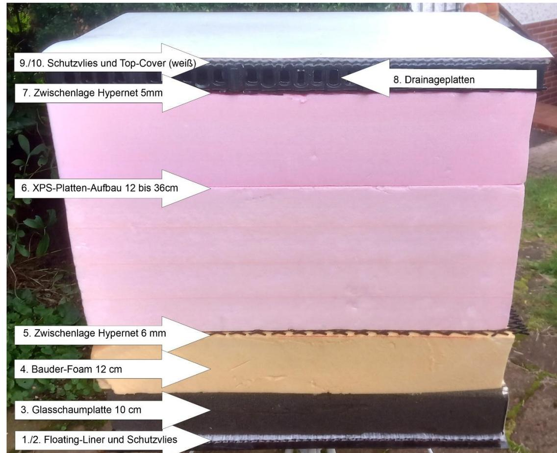
(7) Mit einer weiteren Hypernetschicht, die wie (5) abgerollt wurde, waren die Platten vor dem Wind geschützt, sofern Sandsäcke zur Beschwerung darauf lagen.
