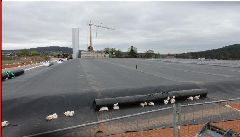
17. April 2025 Die KDB sind schon ein paar Bahnen weit aufgezogen. Rechts im Bild ist noch offenes Wasser. Im Hintergrund Heizzentrale im Bau und der Pufferspeicher. Auf den KDB kann man jetzt schon laufen. Es ist weniger wackelig als befürchtet.
