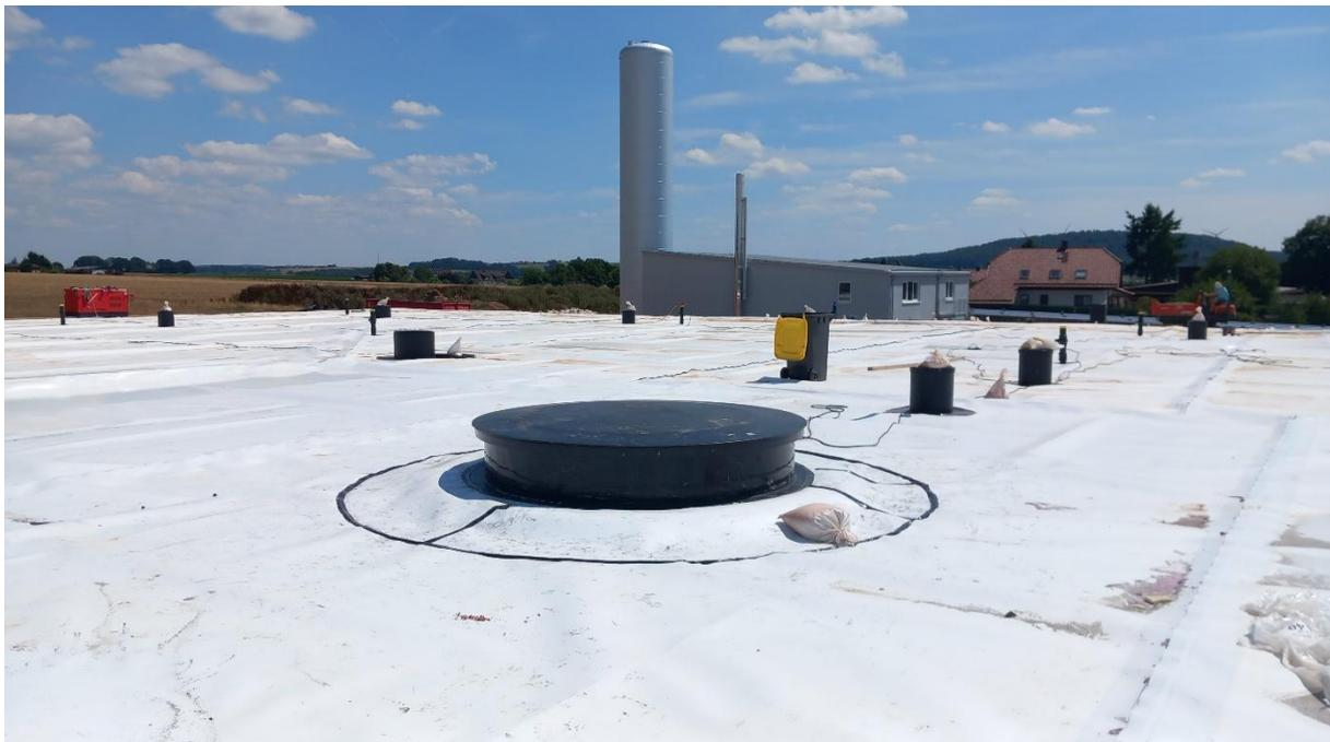
befüllt. Da der Kies nicht reichte, muss hier allerdings noch nachgearbeitet werden. Bei den heftigen Regenfällen am vergangenen Montag hat sich gezeigt, dass die Drainage funktioniert. Das Regenwasser wird über die Ringdrainage nach Westen in unser Versickerbecken abgeführt.
