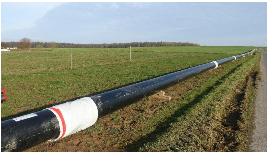
Ein Teil der Verbindungstrasse ist schon vorbereitet.
