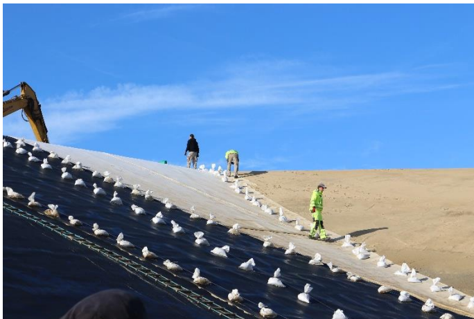
KDB im Vordergrund und Vliesbahnen im Hintergrund in Meldorf (Schleswig-Holstein), fixiert durch Sandsäcke.
