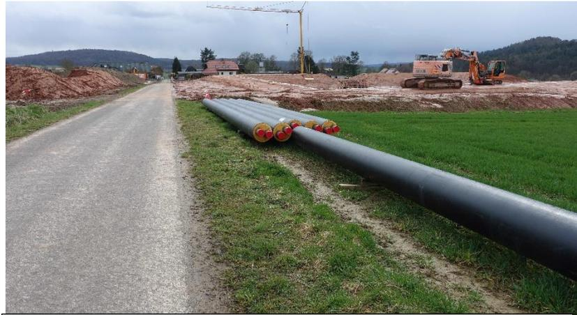
Die Hauptverbindung Siedlung-Bracht dient zunächst der Wasserbefüllung des Speichers und später dem Wärmetransport zwischen den Ortsteilen.
