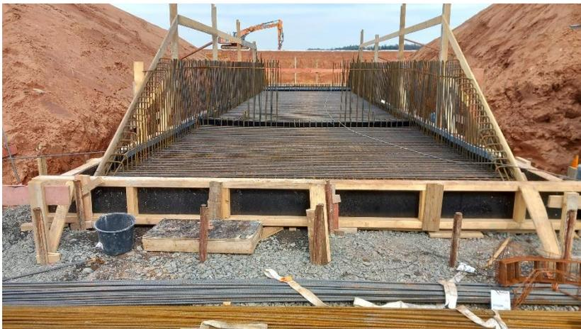
Bewehrungsstahl im Tunnel für die Röhren, die in den Speicher führen. Im Speicher wird das Wasser über Diffusoren verwirbelungsarm ein- und ausgeleitet.
