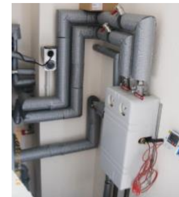
Abbildung Übergabestation/GUT e.V.
